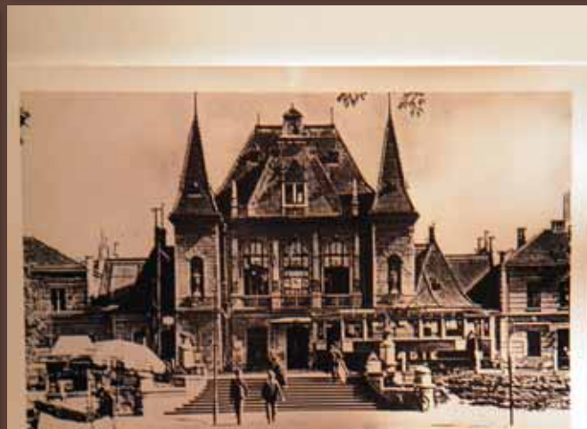
Budova Kotičkej stanice 1932
